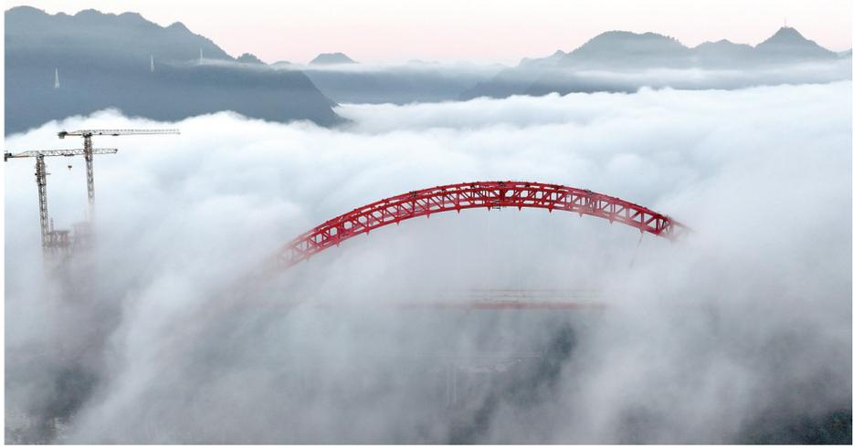
这是11月20日拍摄的建设中的溇水河特大桥(无人机照片)。溇水河特大桥位于湖北省恩施土家族苗族自治州鹤峰县境内，是宜来(宜昌至来凤)高速公路鹤峰东段的控制性工程，大桥全长328米，横跨300多米深的峡谷，目前该桥进入桥面施工阶段。
