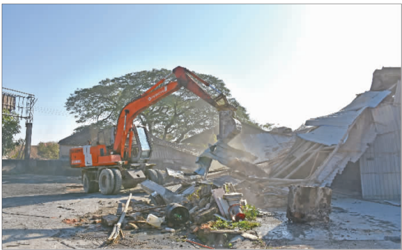
图为涸溪码头建(构)筑物拆除现场。 湘闻 摄
