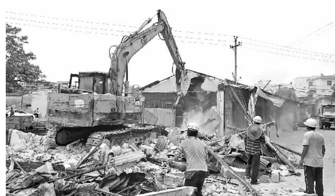
近日,在潮安区庵埠镇薛一村,施工人员正在拆除违建建筑。 陈传森 摄
